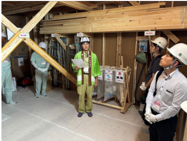
1日5回のそうじを実践している建築現場
