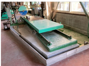
機械周りに溝を切って排水を良くした
