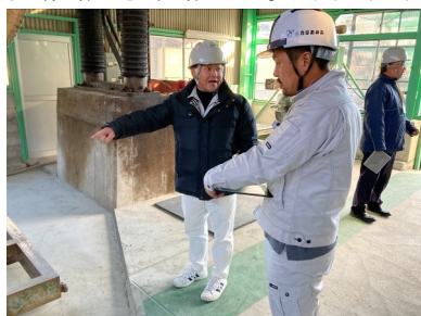
森田社長(左)とリーダーによる現場巡回
