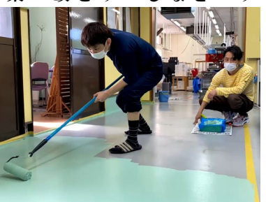
社員のDIYによる床面の塗装作業
