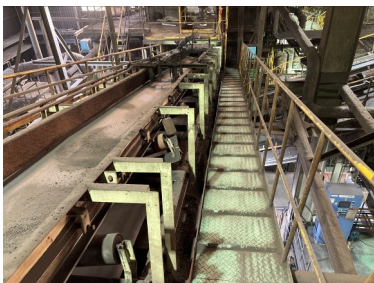
粉塵が除去されたベルトコンベア周囲
