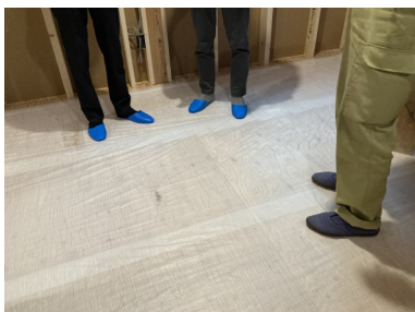
木屑ひとつ落ちていない現場の床面
