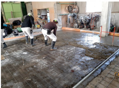
自分たちで床面コンクリートの土間打ち
