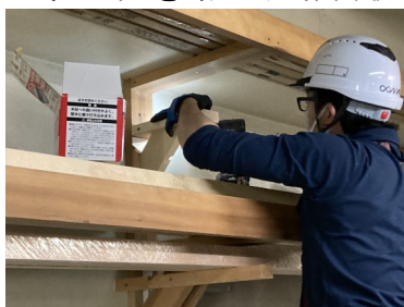
視認性を良くするため柵板を増やす工事
