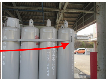
ガスボンベをベルトで固定します
