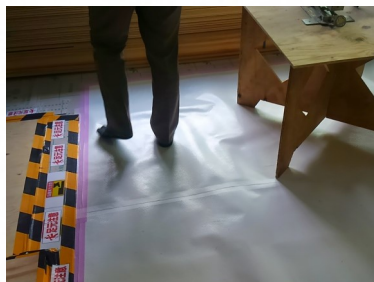
素足で歩ける小河原建設の建築現場
